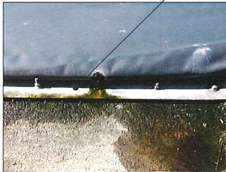
RUBBER LINER LEAKING BATTEN STRIPS
